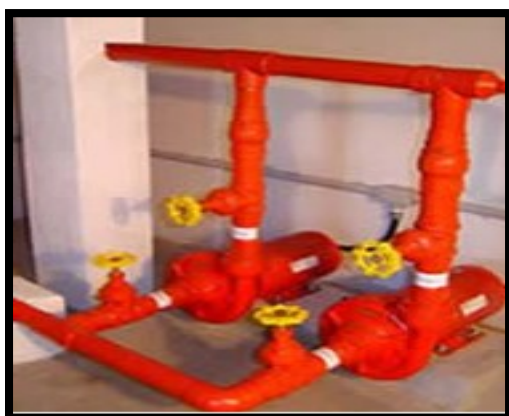
Figura 16 - Bomba de Incêndio
